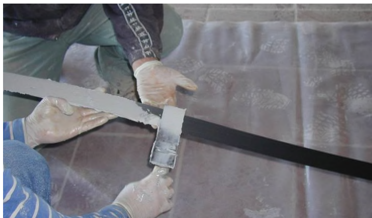
Applicazione di MapeWrap 11/12 (Adesilex PG1/PG2) su Carboplate W
