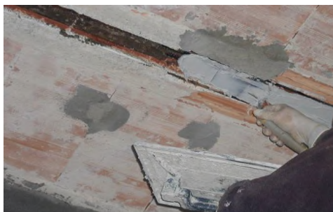
Applicazione di MapeWrap 11/12 (Adesilex PG1/PG2) sul supporto
