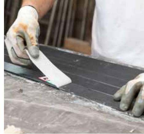
Rimozione peel ply da Carboplate
