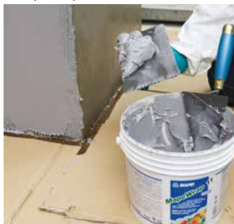
Applicazione di MapeWrap 11 / 12
