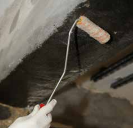
Applicazione di MapeWrap Primer 1
