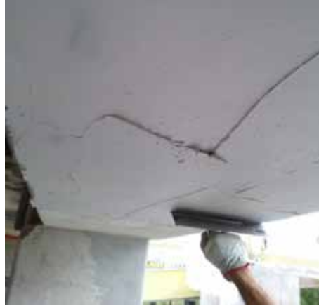
Applicazione di MapeWrap 11/12 su supporto
