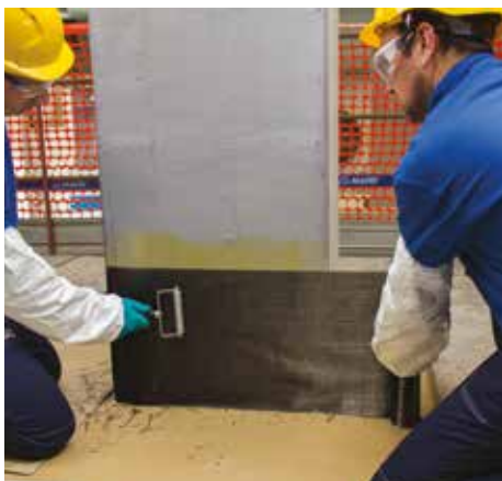
Posa in opera di MapeWrap C UNI-AX
