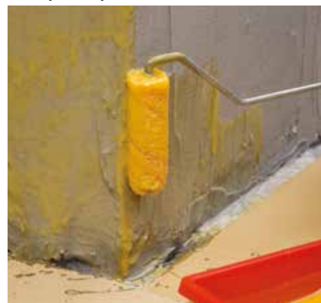
Applicazione della prima mano di MapeWrap 31
