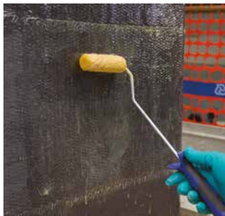
Applicazione della seconda mano di MapeWrap 31
