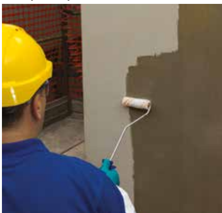
Applicazione di MapeWrap Primer 1
