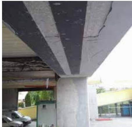
Applicazione di Carboplate
