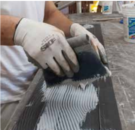
Applicazione di MapeWrap 11/12 su Carboplate
