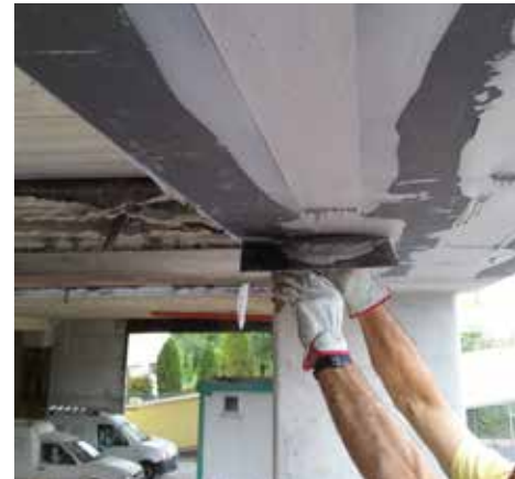
Applicazione di successiva rasatura di MapeWrap 11/12
