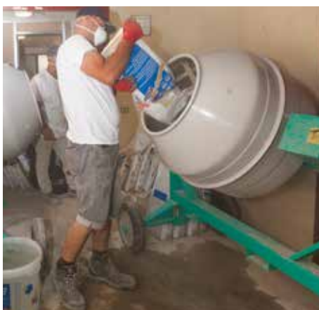
Preparazione della malta
