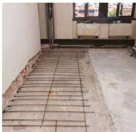
Preparazione del supporto con armature di collegamento alle pareti
