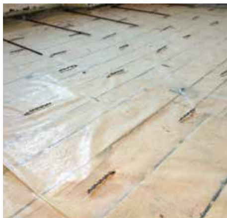
Installazione connettori meccanici tipo Mapei Steel Dry
