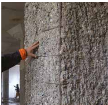
Preparazione del supporto
