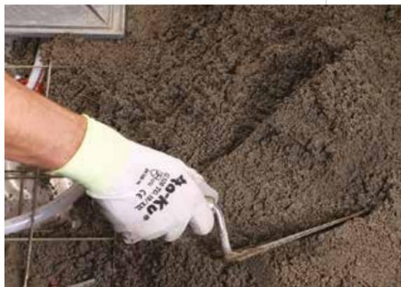
**CARATTERISTICHE** Idoneo per massetti caratterizzati da una classe di resistenza meccanica da **CT-C30-F6** a **C35-F6** (misurata in accordo alla norma UNI EN 13892-1-2) con umidità residua inferiore al 2% dopo 7 di maturazione in condizioni di laboratorio (20°C-U.R.65%).
