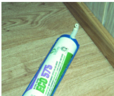
Zoccolino in legno applicato con Ultrabond Eco 575
