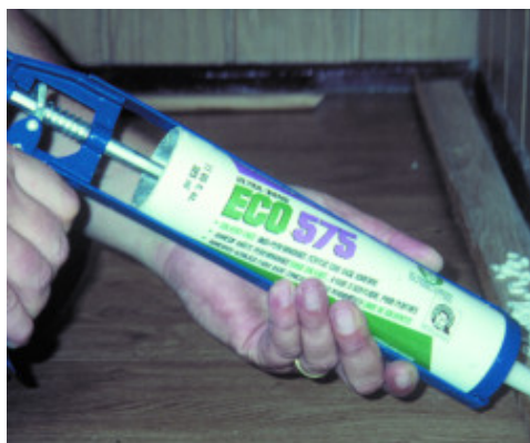
Incollaggio di zoccolino in legno con Ultrabond Eco 575
