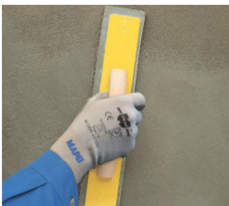
Lisciatura con frattazzino di spugna
