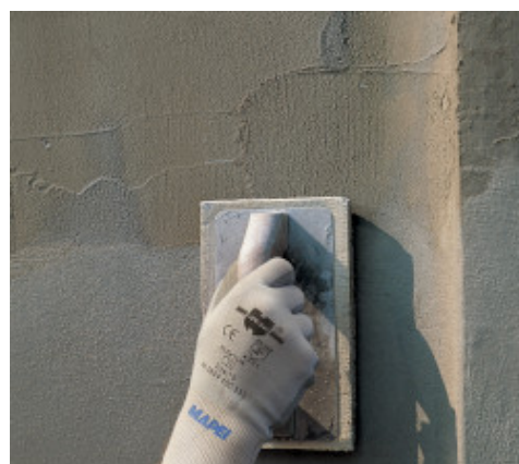
Lisciatura con frattazzino di spugna
