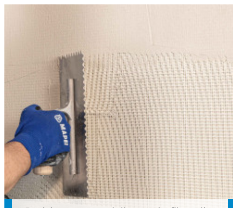
Posizionamento della rete in fibra di vetro A.R. sul primo strato di rasatura
