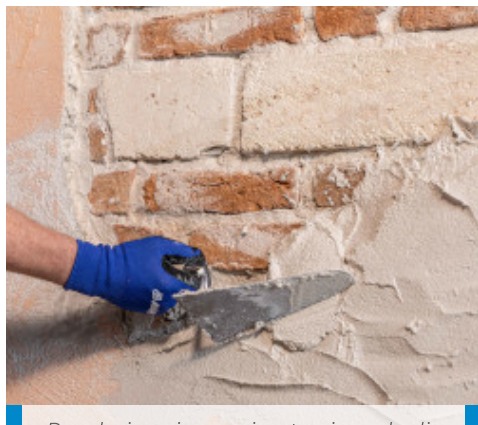
Regolarizzazione e ricostruzione degli intonaci
