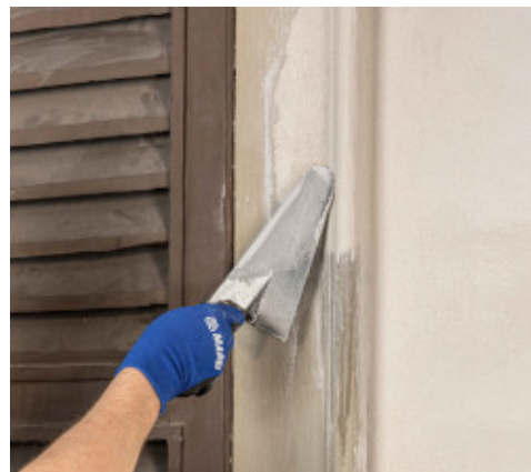
Ricostruzione di elemento costruttivo
