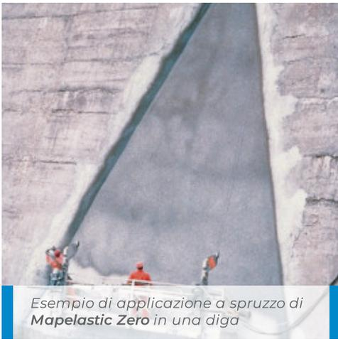
Esempio di applicazione a spruzzo di **Mapelastic Zero** in una diga
