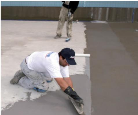
Impermeabilizzazione di una piscina con **Mapelastic Zero**
