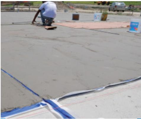
Impermeabilizzazione dei massetti con **Mapelastic Zero** e **Mapeband**
