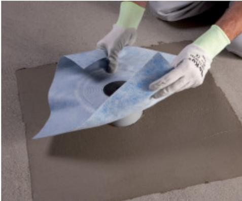
Posa di **Drain Vertical**, pozzetto di scarico, su **Mapelastic Zero**
