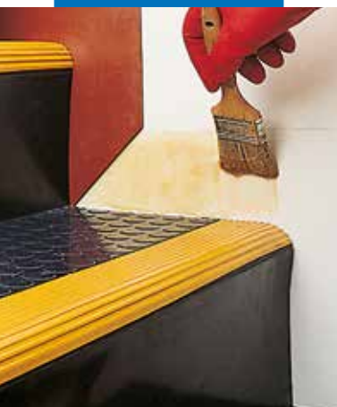
Posa di zoccolino in gomma con Adesilex LP
