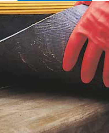
Posa di gomma a bolli con Adesilex LP su gradino
