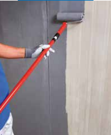
Applicazione di Eco Prim Grip Plus a rullo su supporto in calcestruzzo
