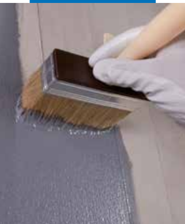
Applicazione di Eco Prim Grip Plus con pennellina su supporto in calcestruzzo
