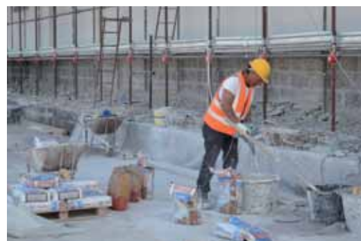
Le facciate dei 7 padiglioni sono state riqualificate con il sistema MAPE-ANTIQUE.
