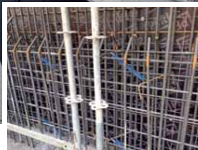
A DESTRA. Posizionamento degli anodi Mapeshield I 30/20 sulle armature da proteggere.
