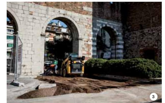
3. Stesura dell'allettamento sciolto costituito da frantumato di porfido con granulometria 4-8 mm.
