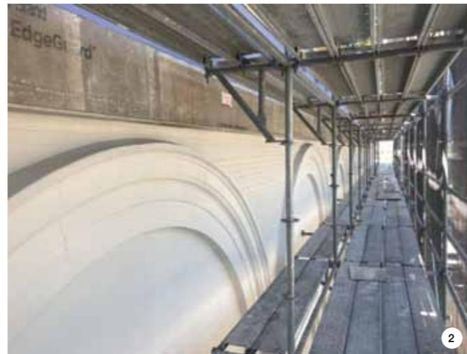
**1, 2.** Le parti ammalorate della superficie in calcestruzzo sono state riparate con PLANITOP X e PLANITOP XS.
