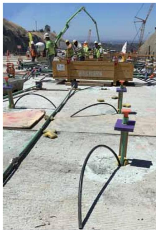
**SOPRA.** La malta PLANIGROUT 755 è stata pompata direttamente nei fori che ospitano le barre di armatura.
