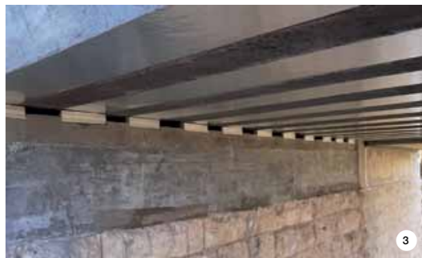
1. Gli anodi di zinco puro MAPESHIELD I 10/20 sono stati fissati ai ferri di armatura del pulvino in calcestruzzo armato. 2. Applicazione delle lamine adesive in zinco MAPESHIELD S. 3. I pulvini sono stati ripristinati e rinforzati strutturalmente utilizzando la malta cementizia colabile PLANITOP HPC. 4. Applicazione del fondo antiruggine DURSILAC NO RUST.
