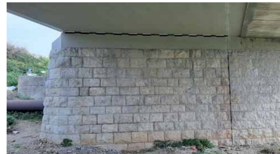
IN QUESTA PAGINA. Due immagini del viadotto a lavori ultimati.
