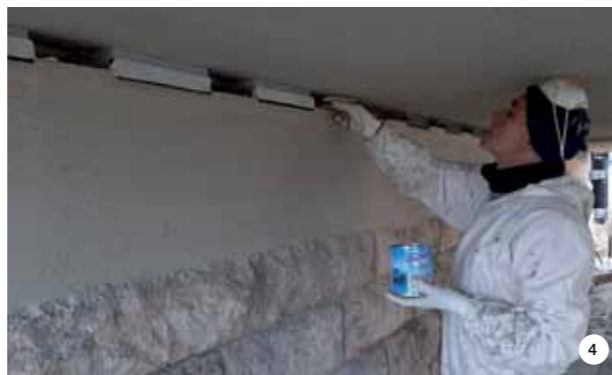
1. Gli anodi di zinco puro MAPESHIELD I 10/20 sono stati fissati ai ferri di armatura del pulvino in calcestruzzo armato. 2. Applicazione delle lamine adesive in zinco MAPESHIELD S. 3. I pulvini sono stati ripristinati e rinforzati strutturalmente utilizzando la malta cementizia colabile PLANITOP HPC. 4. Applicazione del fondo antiruggine DURSILAC NO RUST.
