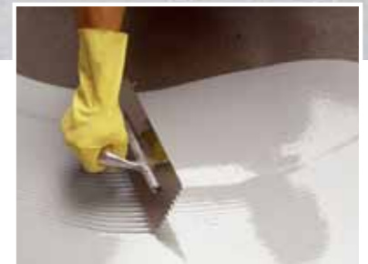
Applicazione con Mapefloor CPU
