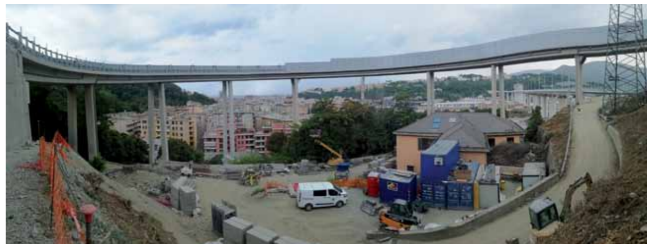
I lavori di ripristino hanno interessato l'impalcato sia all'intradosso che all'estradosso. Sono stati utilizzati diversi prodotti tra cui la malta tissotropica fibrorinforzata MAPEGROUT EASY FLOW e i betoncini colabili MAPEGROUT GF BETONCINO B1 e MAPEGROUT COLABILE B2.
