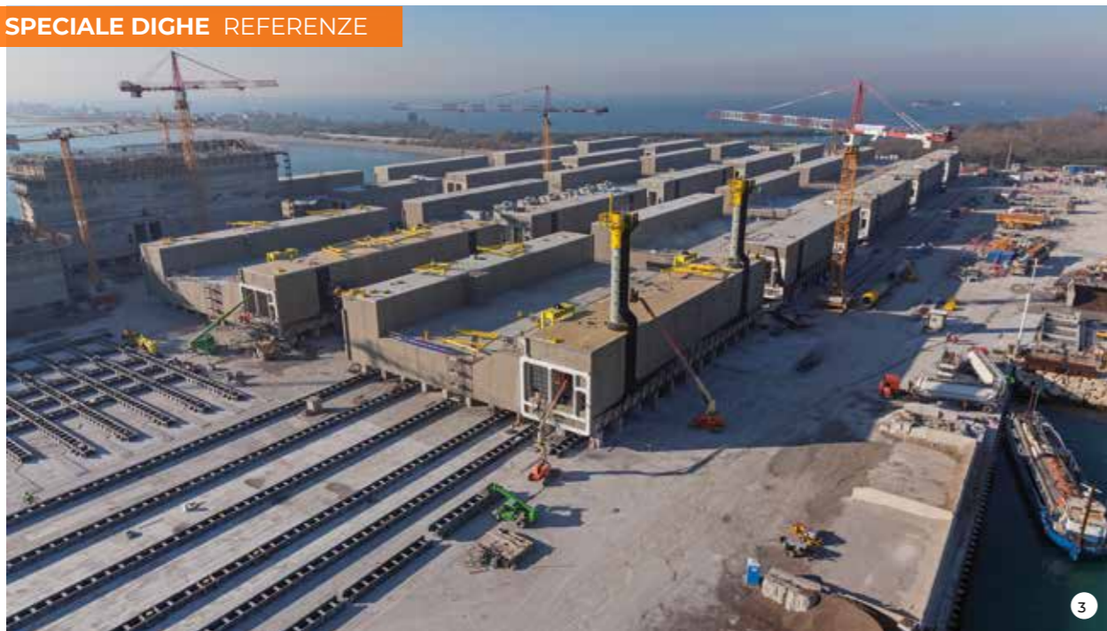
3. I cassoni in via di realizzazione nel cantiere di Malamocco.
