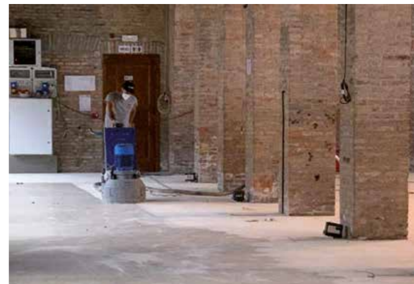
A SINISTRA. La pavimentazione è stata realizzata con il sistema MAPEFLOOR SYSTEM 33, indicato per pavimentazioni industriali soggette a un traffico medio-pesante. Nella foto, il trattamento di levigatura con mole diamantate.
