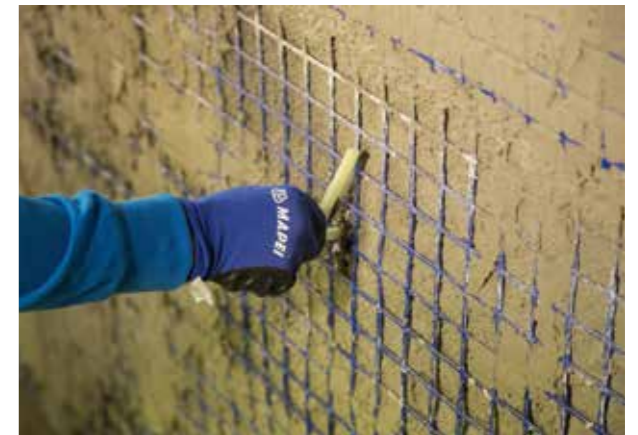
Sistema CRM realizzato con MAPEWALL INTONACA & RINFORZA, MAPENET EM 40 e MAPENET EM CONNECTOR.
