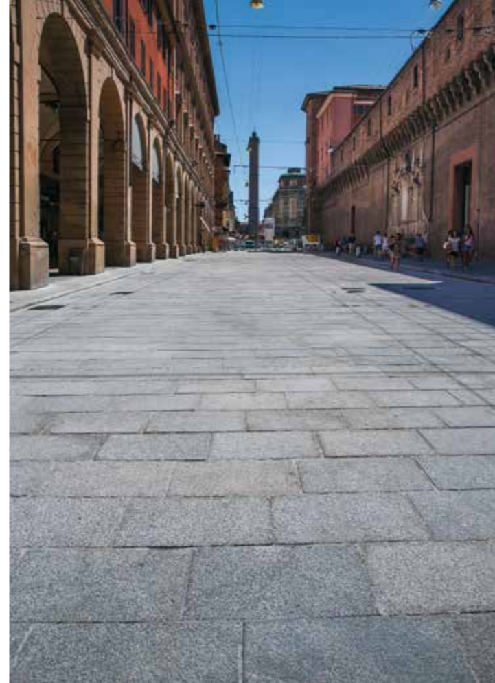
Strada Maggiore a Bologna, che nel 2014 è stata riqualificata utilizzando la malta MAPESTONE TFB 60.
