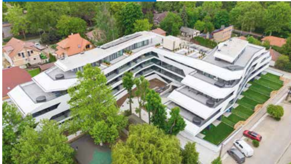
A DESTRA. In questo prestigioso complesso residenziale, realizzato a forma di yacht nella località di Balatonszemes, sono state usate soluzioni Mapei per l'isolamento termico, la finitura delle facciate, l'impermeabilizzazione dei sottofondi e la posa di ceramica.
