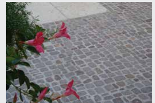
Ciottoli e cubetti, burattati e in vari formati, stuccati con MAPESTONE PFS2 e posati con caratteristico disegno per agevole percorribilità pedonale.
