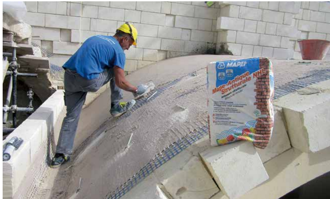
Rinforzo estradossale di volta all'Hotel Palazzo Zicari (Matera).
