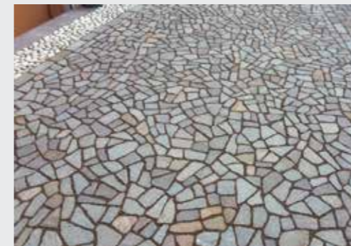
Pavimentazione sigillata con MAPESTONE JOINT e realizzata con vari formati di recupero: ciottoli, cubetti, lastre irregolari (piccola palladiana).
