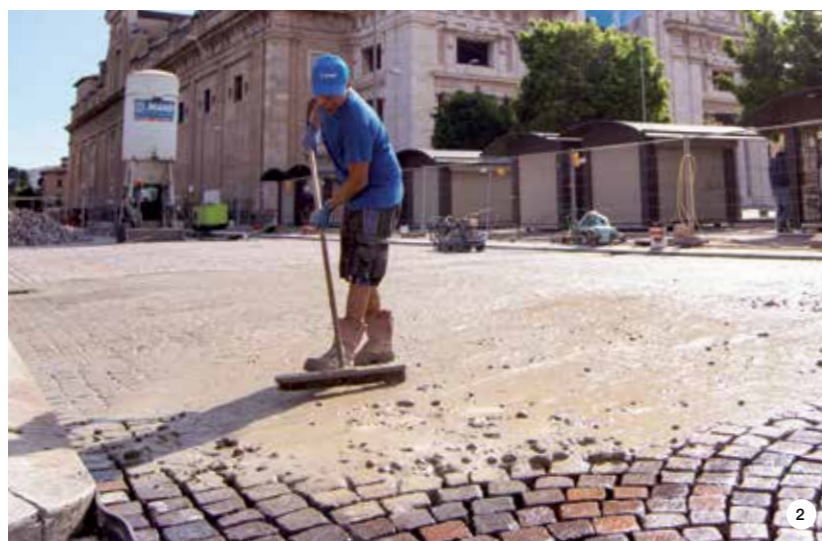
1. Esecuzione della posa con MAPESTONE TFB 60. 2. La stuccatura dei cubetti è stata effettuata con MAPESTONE PFS2 FLEX.
