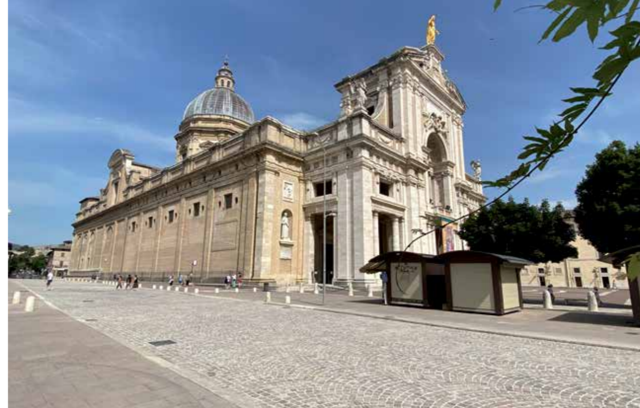
Un'immagine della pavimentazione a intervento ultimato.
