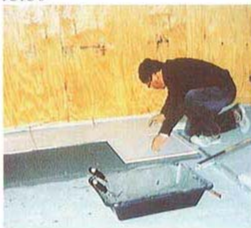
Foto 7 Particolari della pavimentazione posata e pronta per essere fugata con KERACOLOR
