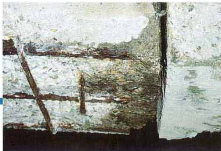
La foto a lato mostra un esempio di ripristino di un pilastro mediante colaggio di MAPEGROUT COLABILE
