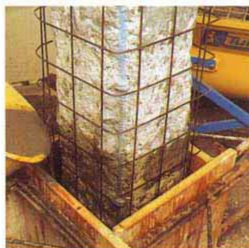
La foto a lato mostra un esempio di ripristino di un pilastro mediante colaggio di MAPEGROUT COLABILE
