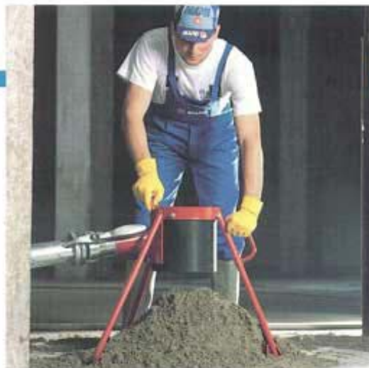
Impasto di TOPCEM posato in opera mediante pompa
