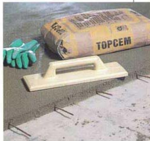
Particolare di massetto in TOPCEM con l'armatura per la ripresa di getto
