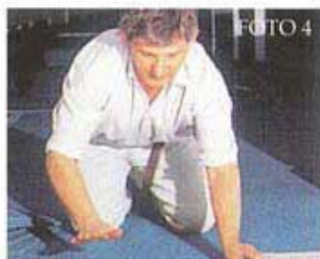
Foto 3 e 4 La posa delle quadrotte autoposanti con MAPEFIX, adesivo in dispersione acquosa ad adesività permanente che, ad asciugamento avvenuto, permette numerose rimozioni e successivi riposizionamenti.
