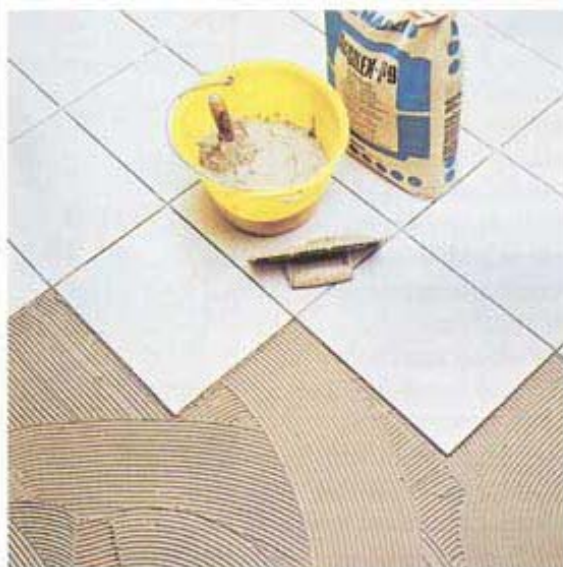
Incollaggio di piastrelle di ceramica
