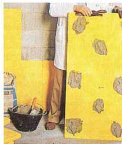
Incollaggio di pannelli isolanti su muro grezzo
