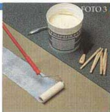
Foto 3 e 4 La posa delle quadrotte autoposanti con MAPEFIX, adesivo in dispersione acquosa ad adesività permanente che, ad asciugamento avvenuto, permette numerose rimozioni e successivi riposizionamenti.
