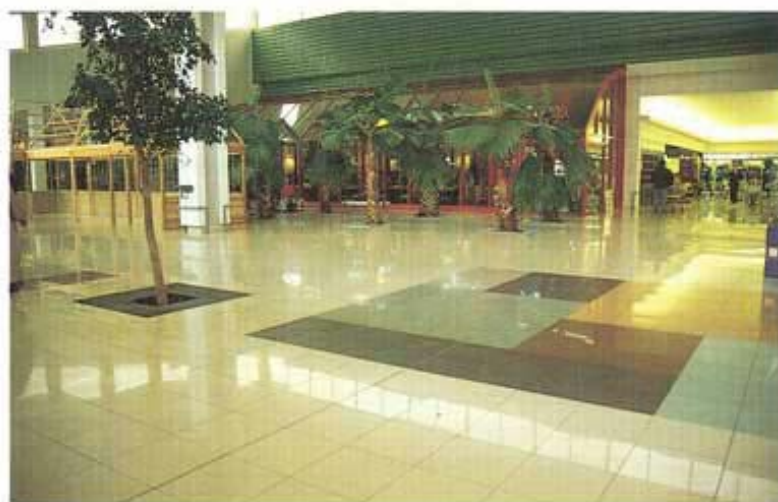
Shopping Center Cora di La Louvière Pavimentazione ripristinata: 4.500 m 2
