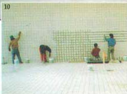
9. 10. Caseificio Bustaffa Bagno S. Vito (Mantova): stuccatura del gres porcellanato a rivestimento
