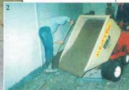
1.2. Centro di distribuzione Provigo - Laval - Canada; getto del massetto e sigillatura
