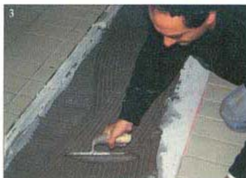
1.2. Centro di distribuzione Provigo - Laval - Canada; getto del massetto e sigillatura
