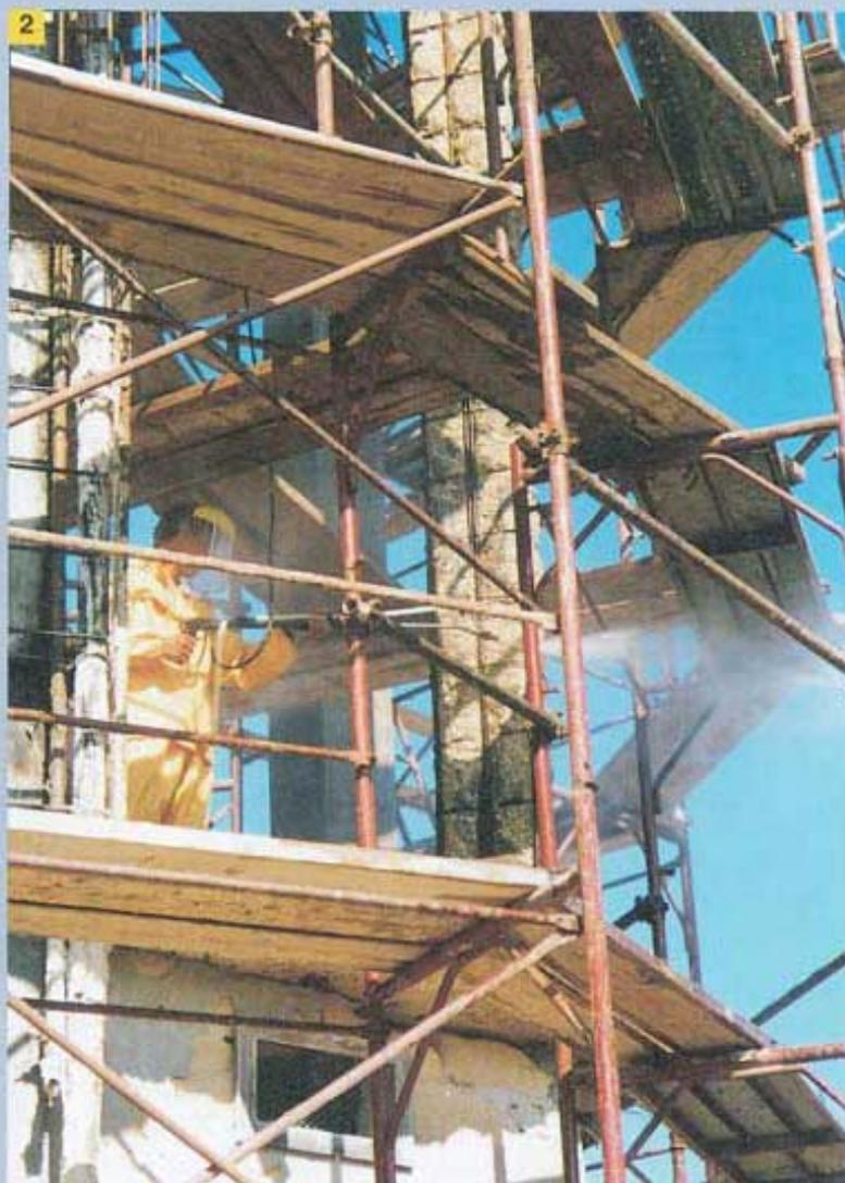
*Foto 2. Fase di preparazione delle superfici mediante lavaggio ad alta pressione, per la completa rimozione di tutte le parti incoerenti.*
