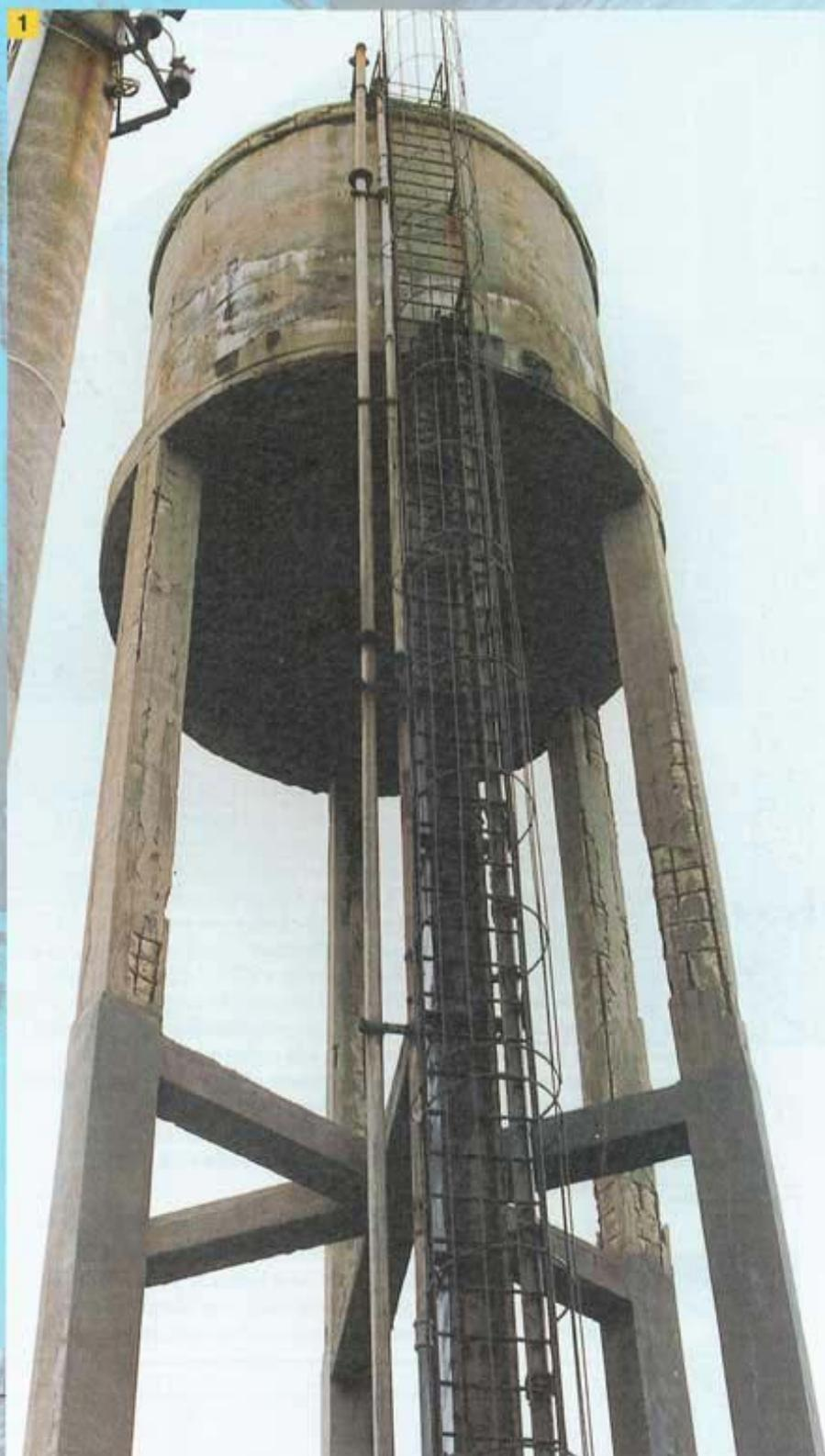
ammalorato con malta tissotropica; rasatura protettiva; protezione e impermeabilizzazione della struttura.
