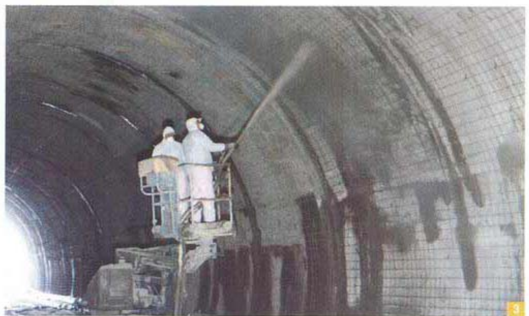
Foto 3. Tecnici in azione durante l'applicazione a spruzzo di Mapegrout Gunite. Si nota chiaramente la rete di acciaio elettrosaldata che ha formato l'armatura dell'intonaco realizzato con Mapegrout Gunite. Il prodotto è stato applicato per mezzo di una pompa a rotore alimentata direttamente con sacchi di prodotto secco, idratato all'uscita dalla lancia di proiezione.
