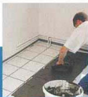
Posa delle piastrelle di ceramica con Keraquick
