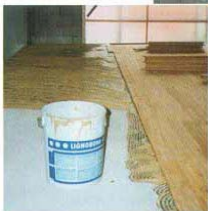
Foto 4. La zona eventi: in primo piano il pavimento in ceramica posato con l'adesivo a base cementizia Keraflex e, più lontano, il parquet incollato con l'adesivo poliuretano Lignobond. Nel particolare, un dettaglio della posa del rivestimento a parete in mosaico ceramico.
