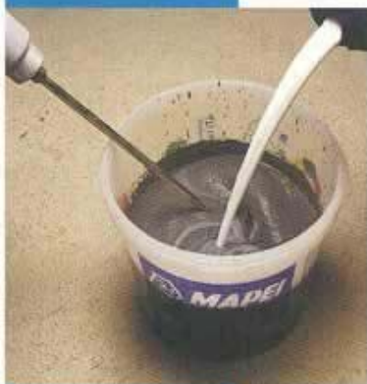
Miscelazione di Planipatch con Latex Plus per rasatura su supporti difficili e deformabili
