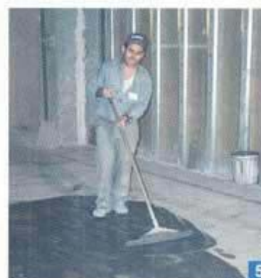
Foto 2. Preparazione del massetto mediante "pallinatura".
