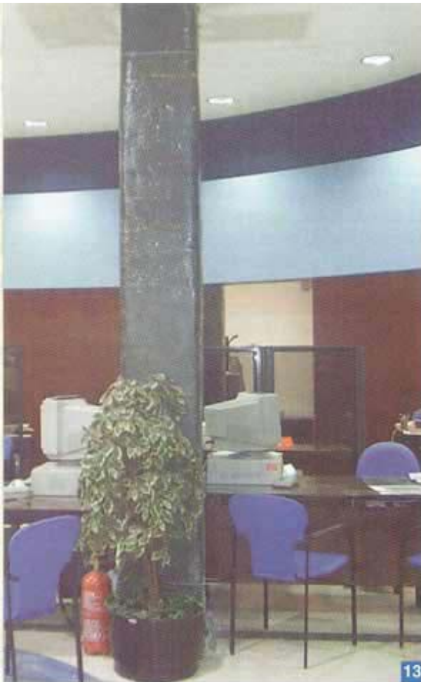
Foto 13. Uno dei pilastri su cui è stato effettuato l'intervento di rinforzo strutturale con FRP System.
