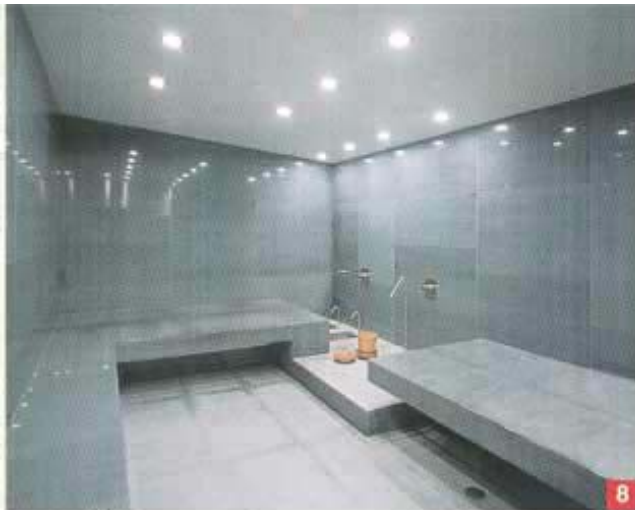
Foto 8. L'hammam, al secondo piano. Il rivestimento in lastre di marmo è stato incollato con Keralastic T, adesivo poliuretano resistente allo scivolamento.
