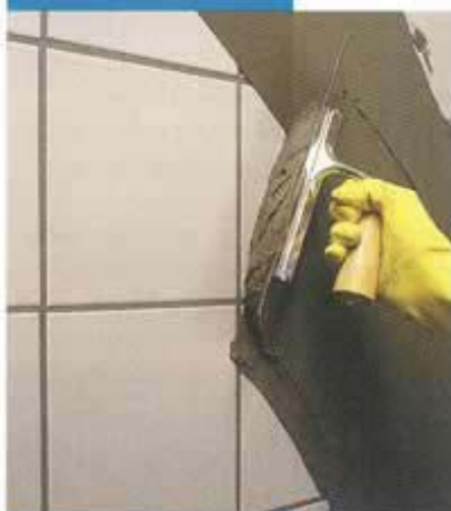
Rasatura di rivestimento esistente con Planipatch
