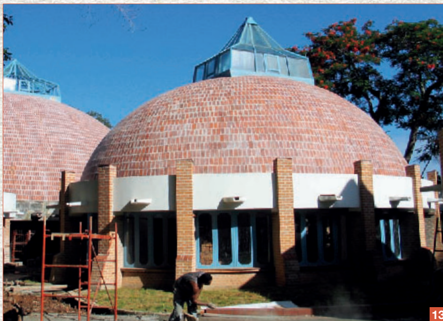
Foto 13. Per la protezione delle strutture rivestite in ceramica sono stati utilizzati gli impregnanti incolori Antipluviol S e Antipluviol W.
