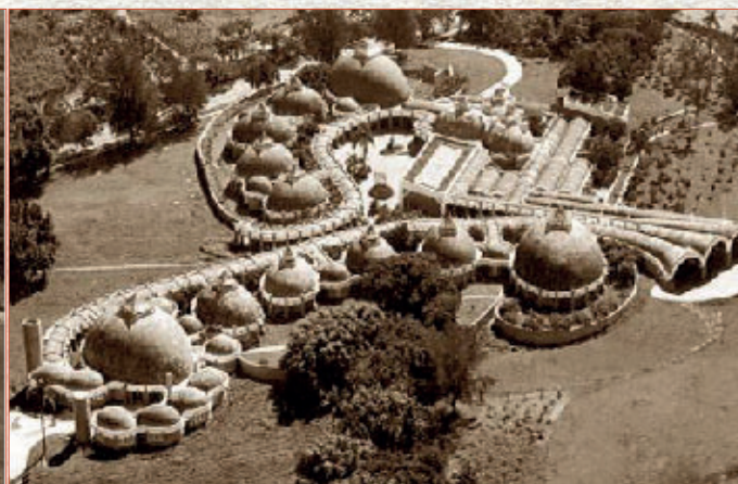
Scuola delle Arti Plastiche prima del restauro
