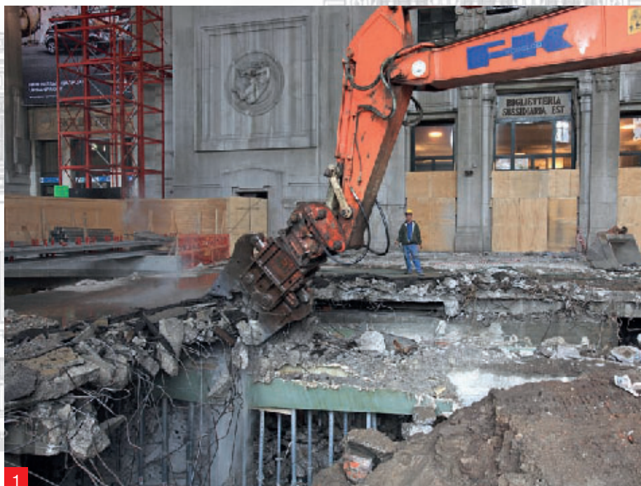
Foto 1. Demolizione della pavimentazione esistente.
