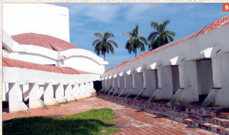
Foto 9. L'intervento è stato completato con la rasatura eseguita con Mapefinish additivato con il lattice Planicrete.
