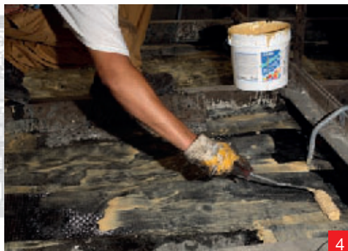
Foto 5. Preparazione per la stesura di MapeWrap C UNI AX.
