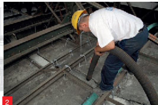
Foto 4. Stesura dell'adesivo MapeWrap 31.
