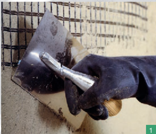
Foto 1. La speciale malta cementizia Planitop HDM in abbinamento a Mapegrid G220.
