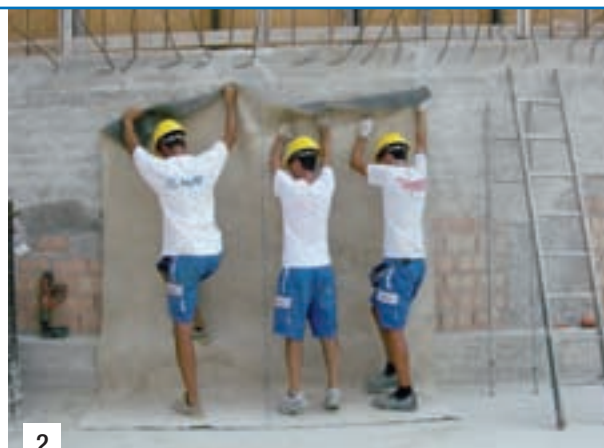
Foto 4. Per fissare i teli sono state utilizzate le rondelle MAPEPROOF CD.
