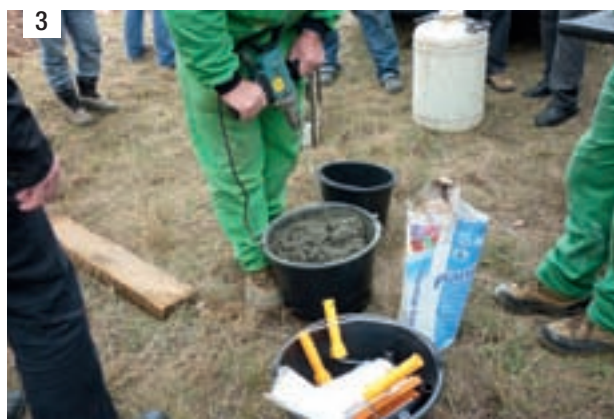
Foto 2. PLANICRETE, miscelato con cemento e acqua, è stato utilizzato per realizzare
