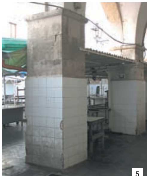
Foto 5 e 6. Pilastri e pareti erano stati rivestiti in piastrelle, poi rimosse.
