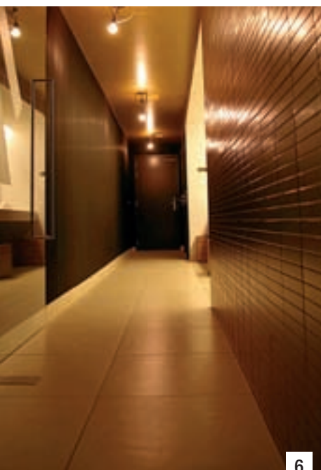
Foto 5 e 6. La superficie dei bagni nelle camere da letto, nella zona ristorante e nell'area wellness è stata inizialmente trattata con PRIMER G e MAPEGUM. WPS. Le piastrelle sono state posate con l'adesivo cementizio KERAFLEX.
