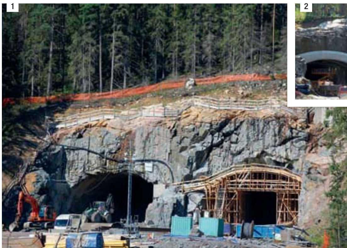
Foto 1 e 2. L'ingresso delle gallerie scavate nella roccia che caratterizzano il tracciato da Muurla a Lohja.
