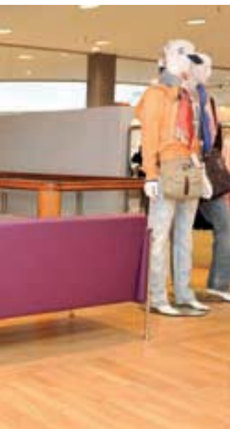
Foto 2, 3 e 4. Per i pavimenti del terzo piano è stato scelto il legno di quercia, posato con ULTRABOND P997 1KT.
