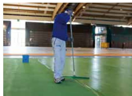
SOPRA. ALCUNE FASI DELLA POSA DI MAPECOAT TNS REMOVE, UN SISTEMA MULTISTRATO CHE PERMETTE DI REALIZZARE CAMPI DA TENNIS REMOVIBILI.
