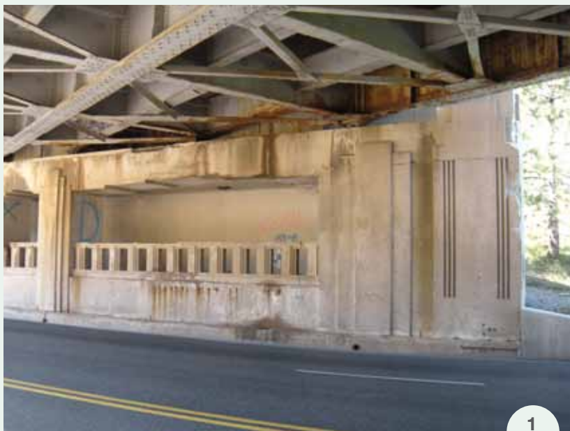
FOTO 3. LE STRUTTURE IN STILE ART DECO DEL PONTE DOPO IL RESTAURO.
