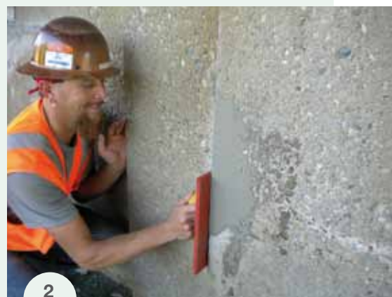
FOTO 2. PER RIPARARE PICCOLE PORZIONI DI SUPERFICIE DEGRADATE È STATO UTILIZZATO PLANITOP X.
