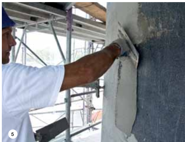
FOTO 5. Il fusto e la base del serbatoio sono stati livellati con il rasante cementizio PLANITOP 207.
