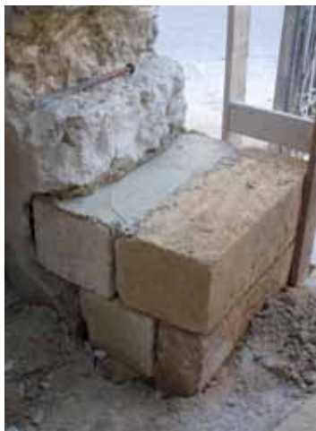
Per ricostruire le murature la malta MAPE-ANTIQUE ALLETTAMENTO è stata applicata a cazzuola, previa saturazione dei conci. Per le connessioni tra setti murari e la struttura portante è stato utilizzato l'ancorante chimico MAPEFIX VE SF.
