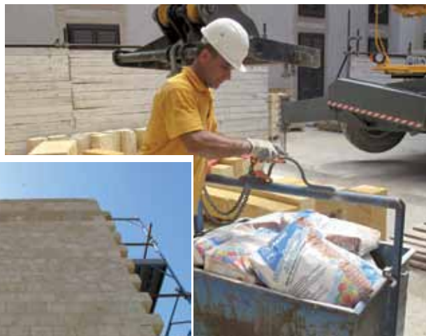
Per ricostruire le murature la malta MAPE-ANTIQUE ALLETTAMENTO è stata applicata a cazzuola, previa saturazione dei conci. Per le connessioni tra setti murari e la struttura portante è stato utilizzato l'ancorante chimico MAPEFIX VE SF.
