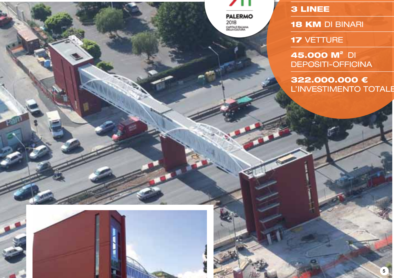
FOTO 4 e 5. Sulle strutture in calcestruzzo dei sovrappassi pedonali è stata applicata la vernice protettiva ELASTOCOLOR PITTURA.
