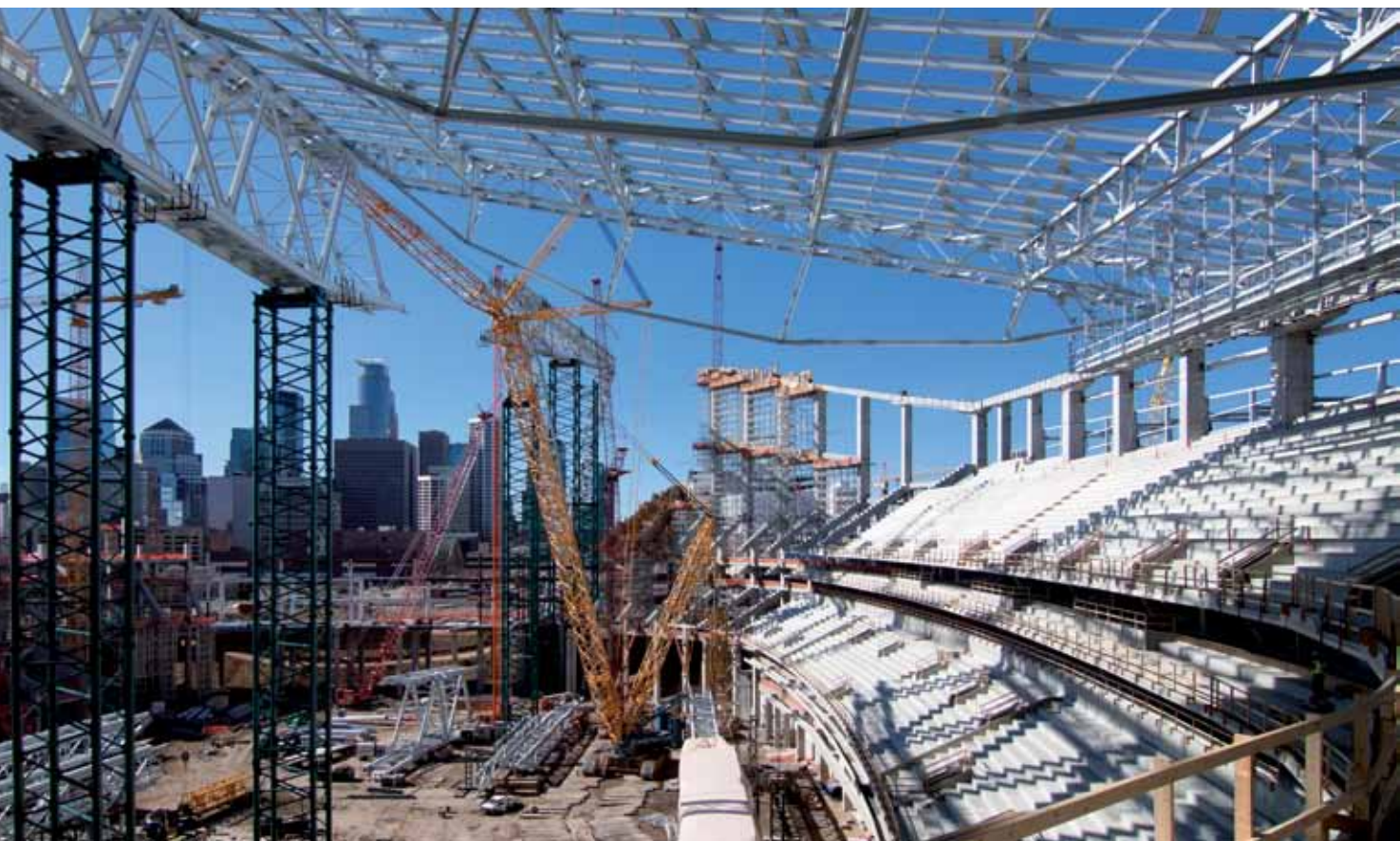
SOPRA. L'esterno dello stadio in fase di costruzione. SOTTO. La realizzazione della copertura poi completata con la membrana in Efte.
