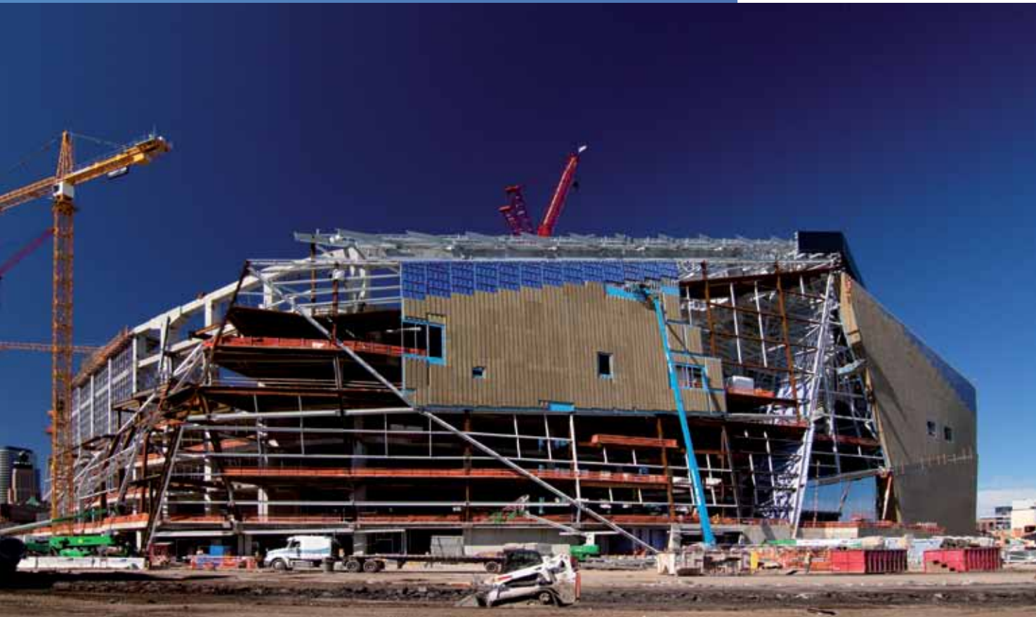
SOPRA. L'esterno dello stadio in fase di costruzione. SOTTO. La realizzazione della copertura poi completata con la membrana in Efte.
