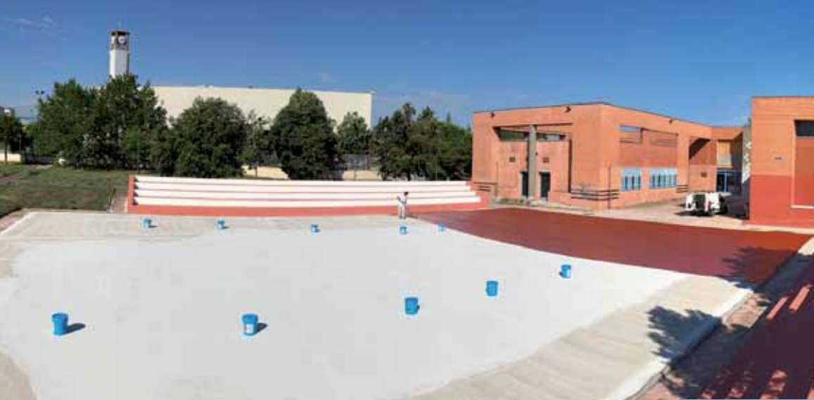
A SINISTRA. Una fase del lavoro di riqualificazione del campo di calcio a 5 nel quartiere San Pio a Bari, che ha visto l'utilizzo dei prodotti della linea MAPECOAT TNS MULTISPORT PROFESSIONAL. SOTTO. Il campo a lavori ultimati.
