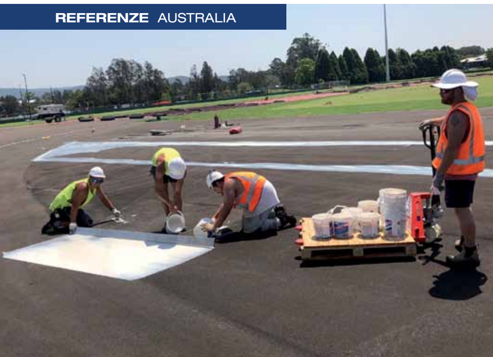
La posa della pista, dopo la rasatura delle superfici, è stata effettuata con ADESILEX G19.
