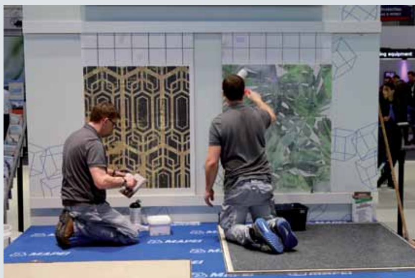
Dimostrazioni di posa di fibra di vetro utilizzando i prodotti della Linea Decor.
