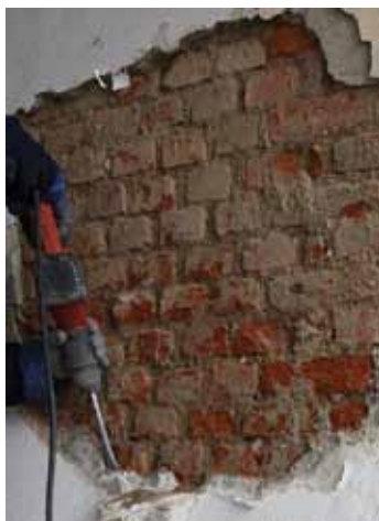
Rimozione dell'intonaco degradato.
