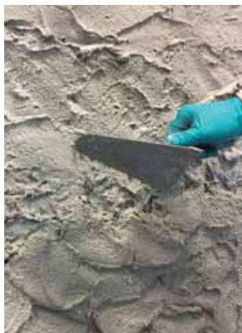
Applicazione con cazzuola di POROMAP DEUMIDIFICANTE.
