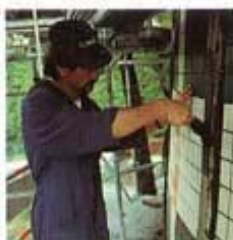
Dall'alto in basso, le fasi dell'intervento: foto 1, applicazione di MAPEFER; foto 2, riporto di MAPEGROUT TISSOTROPICO; foto 3, posa con KERABOND più ISOLASTIC; foto 4, verniciatura con MAPECOLOR.
