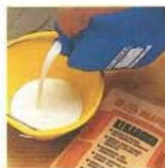
Sopra, l'additivo in polvere KERABOND viene miscelato con il lattice elasticizzante ISOLASTIC per rendere flessibile la posa delle piastrelle di klinker in facciata.
