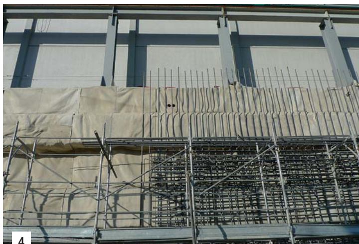
Foto 3. Posa di MAPEPROOF sui pali. Foto 4. Particolare del trattamento delle travi di coronamento.
