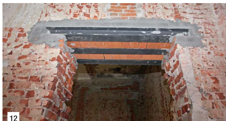
Foto 11. Per incollare e sigillare le putrelle in acciaio sulle pareti è stato usato ADESILEX PG1. I raccordi tra il telaio metallico e la struttura circostante in calcestruzzo sono stati riempiti con MAPEGROUT COLABILE.
