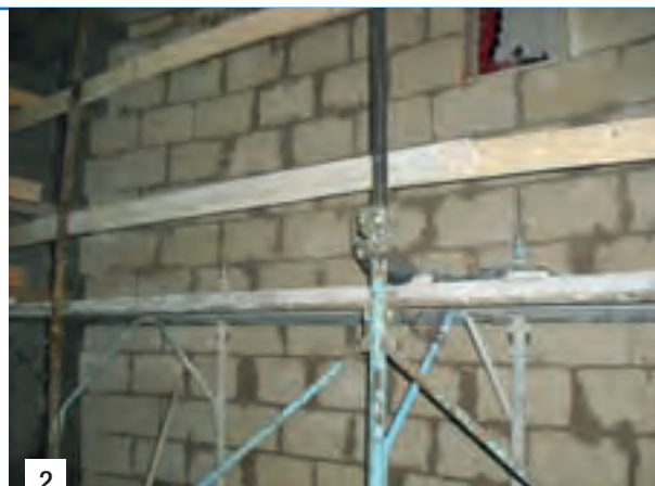
Foto 2. L'applicazione dei prodotti Mapei ha avuto inizio con la realizzazione degli intonaci sui muri in tufo del nuovo foyer con la malta premiscelata INTOMAP R1. Il prodotto è stato utilizzato anche per rifare gli intonaci nei corridoi e nei bagni.
