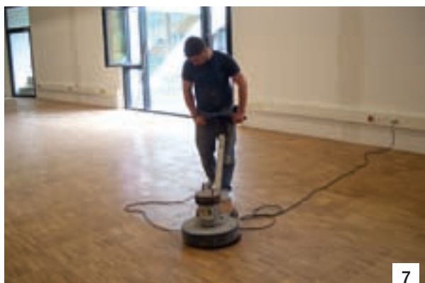
Foto 6. Dopo l'applicazione di ULTRACOAT OIL, la superficie è stata lucidata con un'elicotteratrice munita di appositi dischi bianchi ULTRACOAT PAD. Un'altra elicotteratrice munita di panno di cotone è stata usata per rimuovere l'olio in eccesso.
