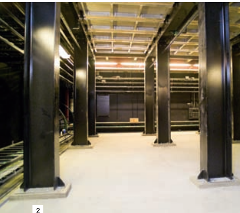
Foto 2. Rescon Mapei ha fornito una serie di prodotti per l'incollaggio strutturale e per gli ancoraggi delle parti metalliche: MAPEPOXY LR, MAPEPOXY UV-L, MAPEPOXY BI, NONSETT 120.
