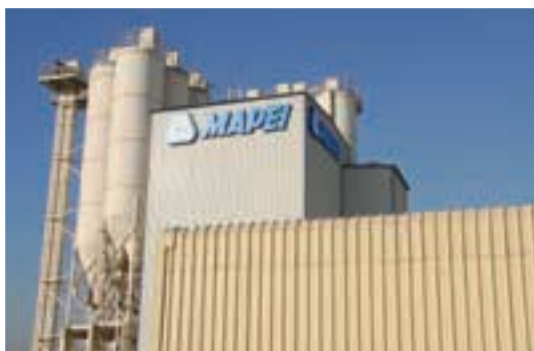
L'impianto di produzione Mapei, localizzato presso il Dubai Investments Park.
