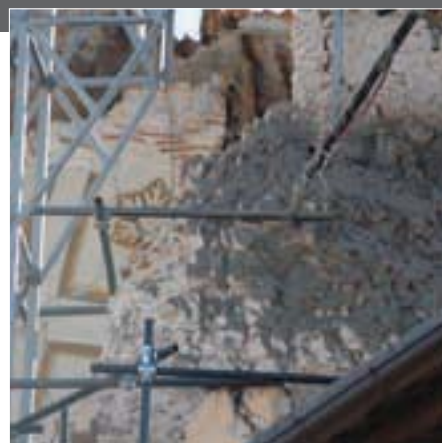
Fase del restauro
