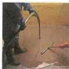
*Sopra, impasto di ULTRAPLAN con agitatore meccanico; applicazione di ULTRAPLAN con pompa e successiva raclatura*
