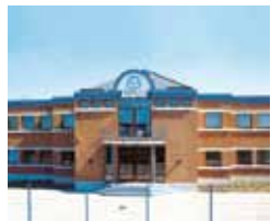
Mapei Benelux S.A./N.V. Grâce-Hollogne (Liège) - Belgio
