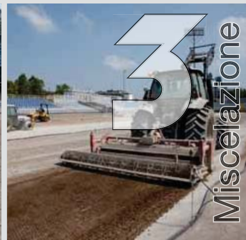
Miscelazione di Mapesoil 100 con fresa
