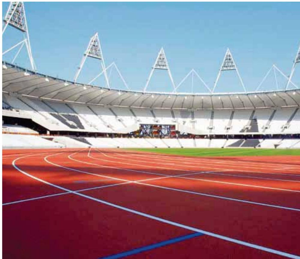
stata ridotta del 40% l'energia grigia (cioè la quantità di energia necessaria per produrre, trasportare fino al luogo di utilizzo e smaltire un prodotto o un materiale o assicurare un servizio); l'anello finale dello stadio è stato realizzato con elementi di tubature del gas in eccedenza.
