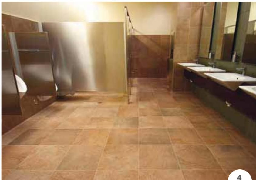
**Foto 4.** L'adesivo ULTRAFLEX LFT è stato usato per posare piastrelle ceramiche (delle dimensioni 46x46 cm) su pareti e colonne di alcuni bagni. Le fughe sono state stuccate con OPTICOLOR.
