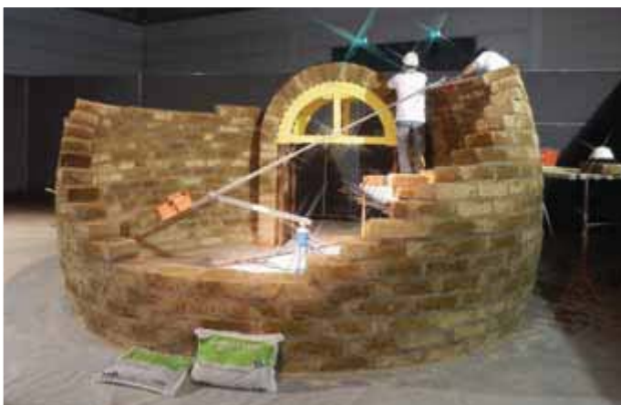
La "Cupola Carola" è stata costruita nei giorni della fiera attraverso la posa manuale "pietra su pietra" di blocchetti di tufo viterbese allettati con MALTA BASTARDA, prodotto di VAGA, consociata del Gruppo Mapei.
