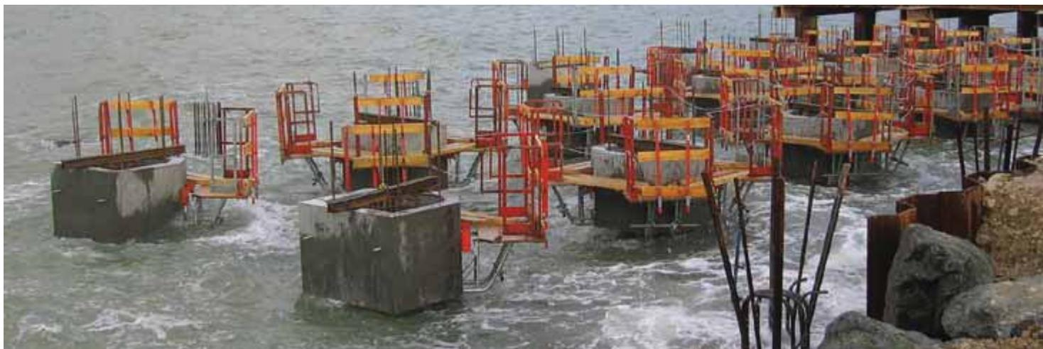
sono stati utilizzati un additivo accelerante di indurimento e un superfluidificante Mapei:
