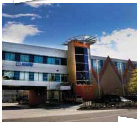
Stabilimento Mapei di Delta (Canada) (certificazione LEED)
