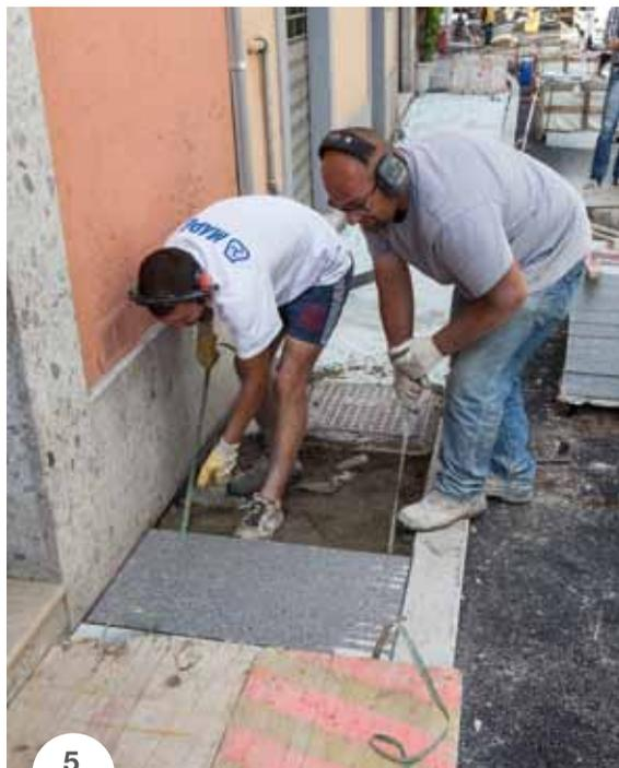
d'allettamento non ha ancora ultimato la presa. La malta di stuccatura è stata miscelata con sola acqua per almeno 3 minuti con un sistema meccanico adeguato (es. betoniera verticale o trapano miscelatore) fino ad ottenere una consistenza omogenea colabile. L'applicazione della miscela viene di solito eseguita mediante colatura per mezzo di un recipiente con "beccuccio" o tramite "racla" gommata. I residui della stuccatura sono stati rimossi con acqua e spugna prima che il prodotto indurisse.
