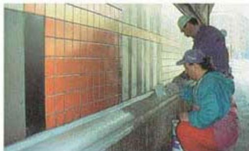
ammalorato e pulizia delle superfici mediante pompa idrogetto che spruzza acqua alla pressione di 800 atmosfere;
