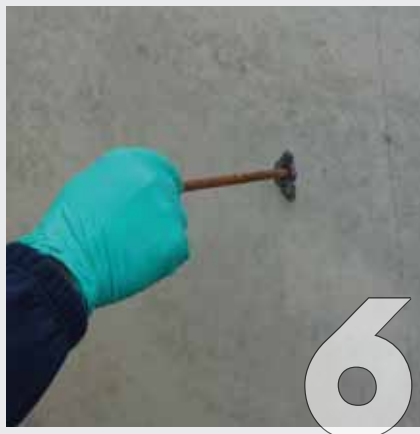
Inserire nel foro la barra metallica con un leggero movimento rotatorio.
