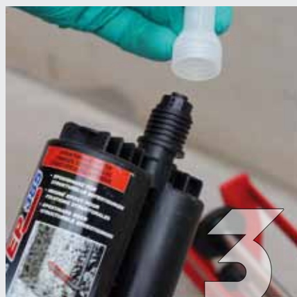
3 Avvitare il miscelatore statico sulla testa della cartuccia.
