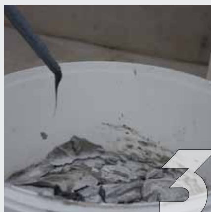
3 Eliminare le tre prime pompate di resina.
