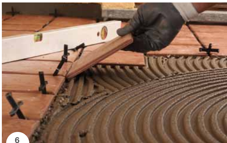
FOTO 6. Dopo l'intervento di impermeabilizzazione le piastrelle in gres porcellanato sono state posate con l'adesivo cementizio KERAFLEX.
