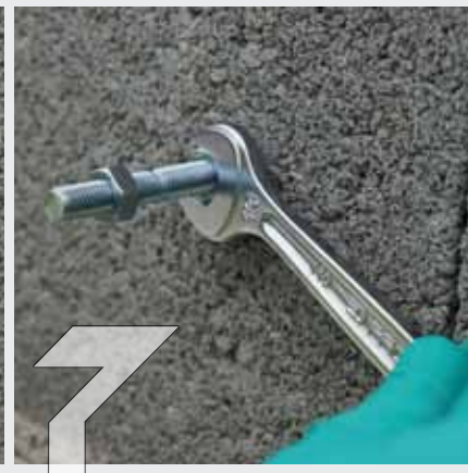
A indurimento avvenuto, l'ancoraggio può essere utilizzato.
