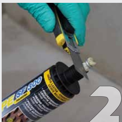
2 Prima di avvitare il miscelatore statico sulla testa della cartuccia, tagliare in corrispondenza dell'anello.
