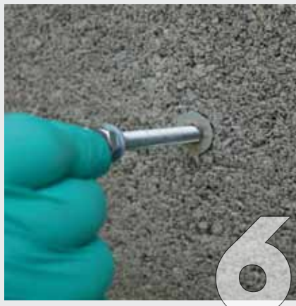
Inserire nel foro la barra filettata con un leggero movimento rotatorio.
