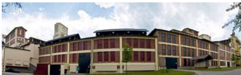
Lo stabilimento della consociata Górka.
