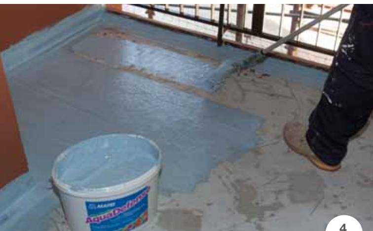
FOTO 4. L'intervento di impermeabilizzazione è iniziato con la stesura della membrana liquida elastica MAPELASTIC AQUADEFENSE.
