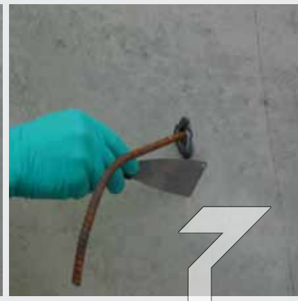
Verificare che la resina in eccesso fuoriesca e rimuoverla dal contorno del foro.
