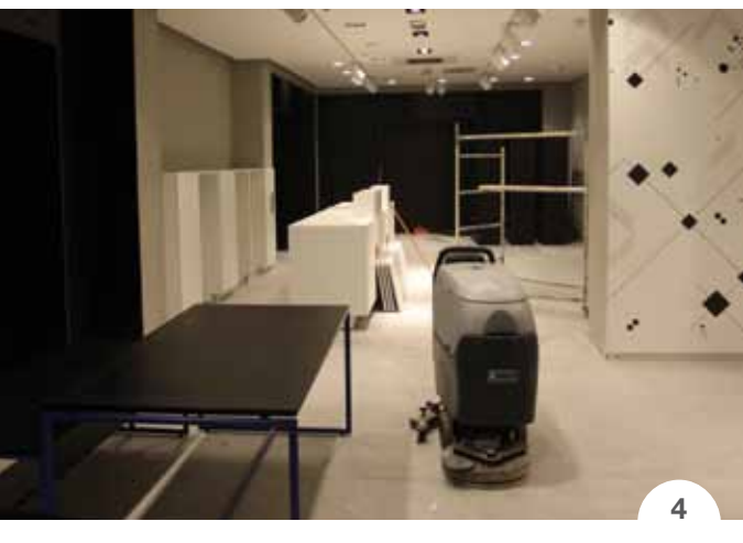
FOTO 4. Carteggiatura del massetto in TOPCEM PRONTO.
