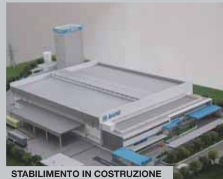
STABILIMENTO IN COSTRUZIONE
