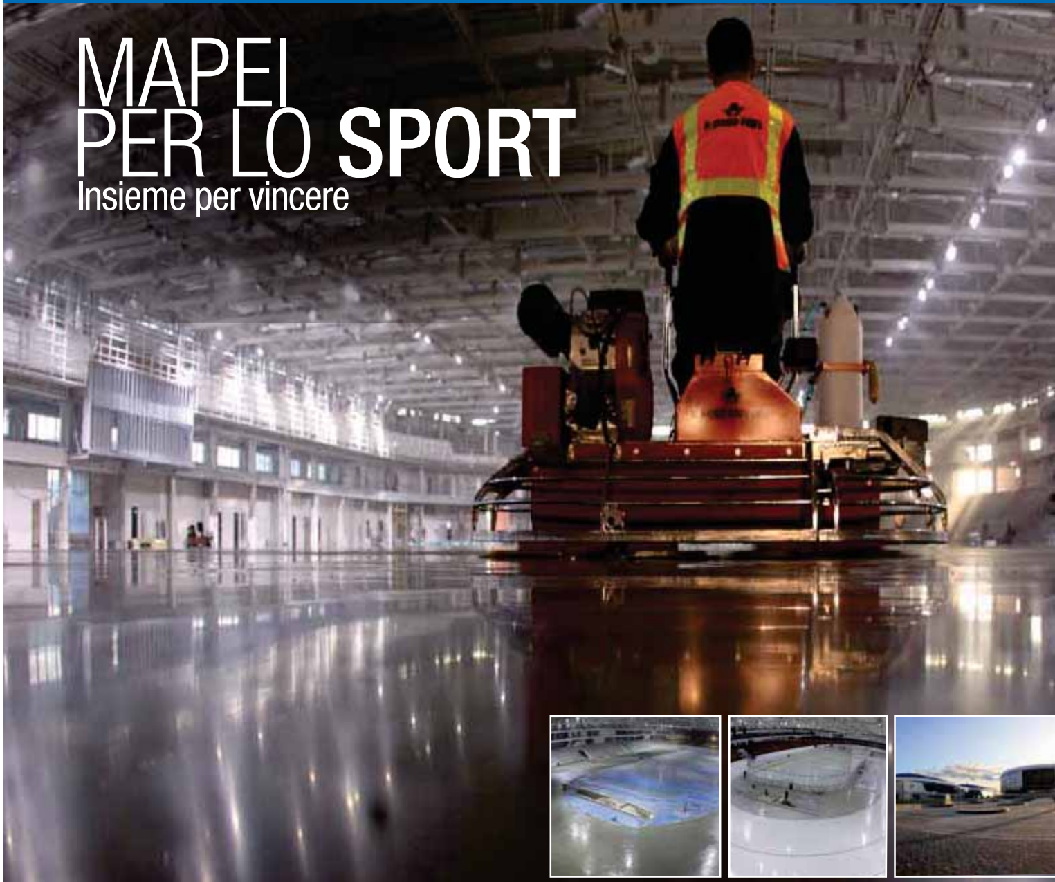
Palaghiaccio Minsk, Bielorussia Realizzazione di pavimentazione in calcestruzzo con Mapecrete System
